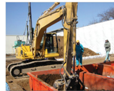
■ 汚染土壌の処理
